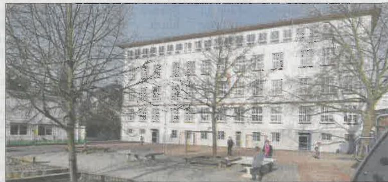
Die Diesterwegschule ist in die Jahre gekommen. Sie soll zum Teil saniert, zum Teil abgerissen und neu gebaut werden. Fotos: Rainer Ruffer
